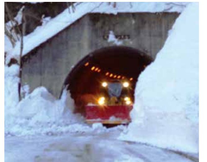
大滑トンネル出口。雪崩の除去(2月22日 本人撮影)
