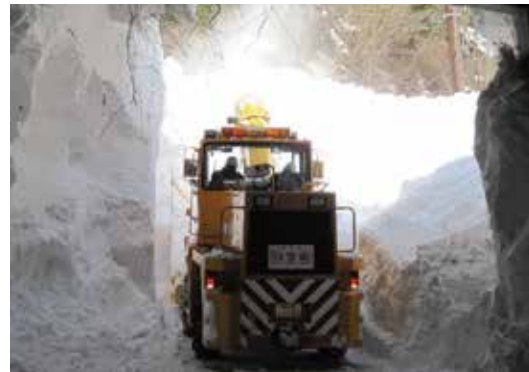
トンネル切り開いた直後。雪の高さに圧倒される。
