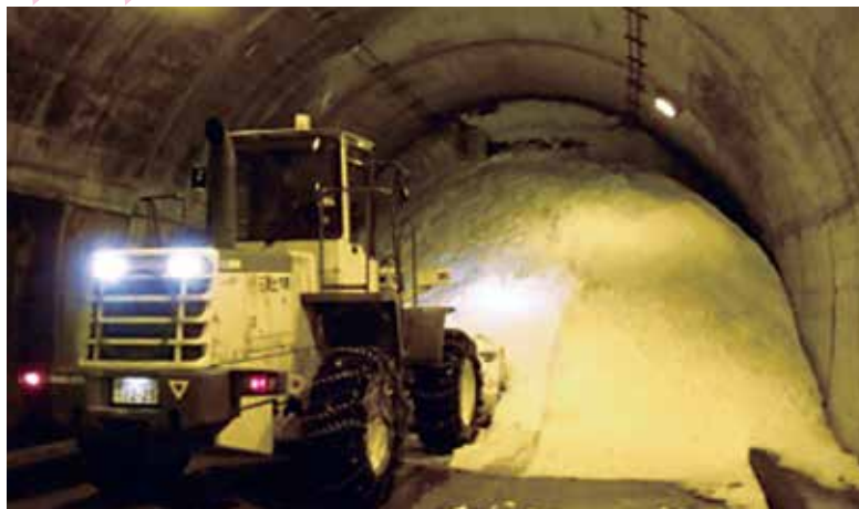
トンネルを雪が完全に埋め尽くす(秩父 大滑トンネル)
